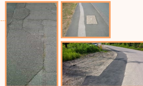
Dovezi de sapaturi anterioare/urme pentru utilități
