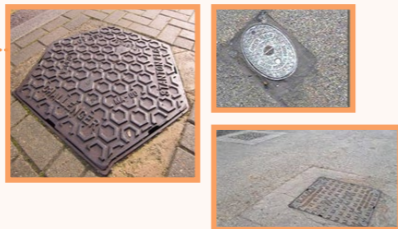
Cămine/conducte/capace de acces/puncte de tragere pentru drenaj
