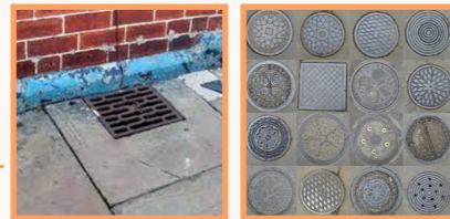
Rostogoluri pentru cărbune, trape (posibil subsol) și orificii de ventilație
